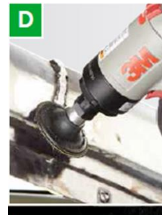
Удаление сварных швов
