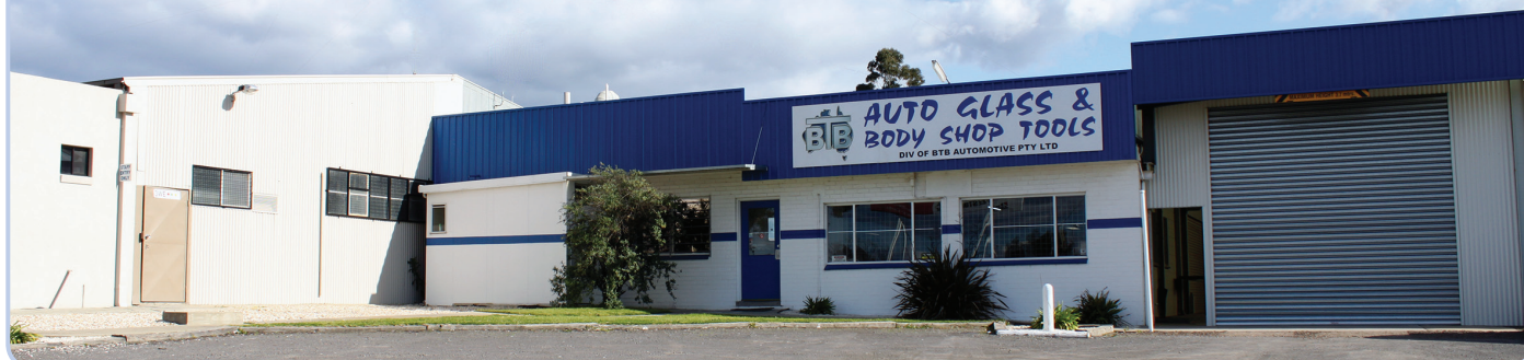
Головной офис ВТВ Tools, Производство и складской комплекс
