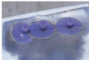
Ремонт емкости из стали
